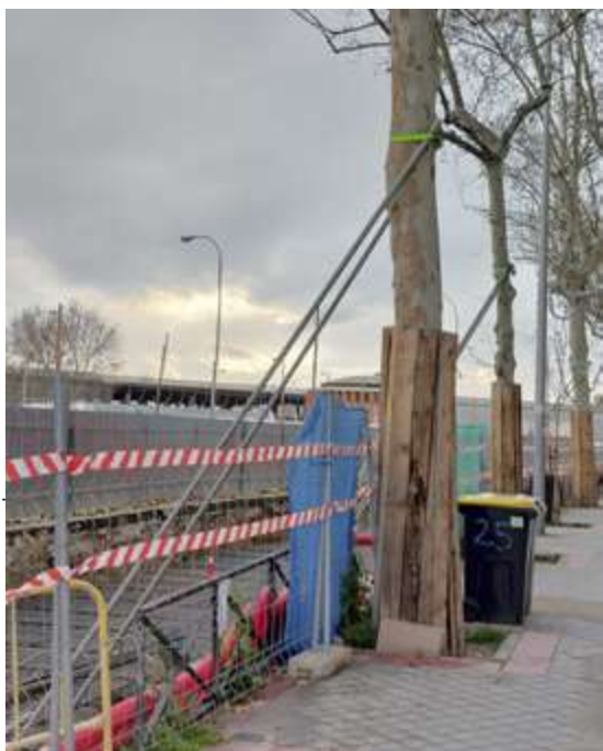
Un cas exceptionnel de maintien des arbres lié au creusement d'une vaste infrastructure enterrée. Les arbres sont tenus avec des barres métalliques fixées au tronc par une sangle. Madrid, 2025.
