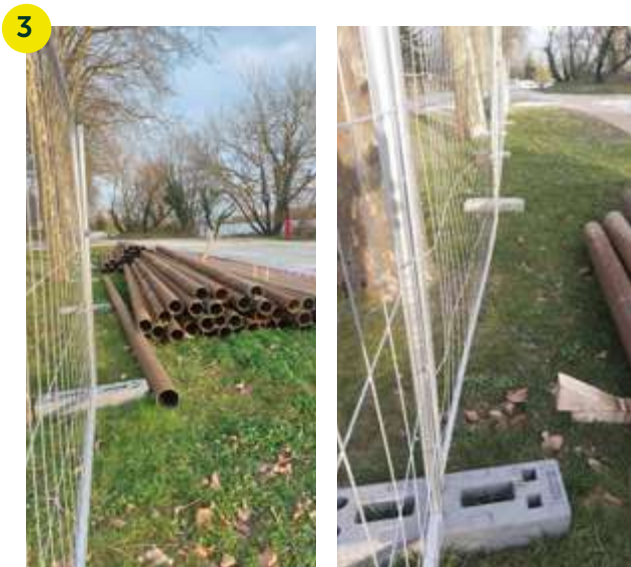
Les tubes en acier destinés à être enfoncés dans le bas de la berge sont entreposés au pied des arbres, avec l'accord du maître d'œuvre et du gestionnaire des arbres à la condition que les tubes reposent sur des supports en bois.
