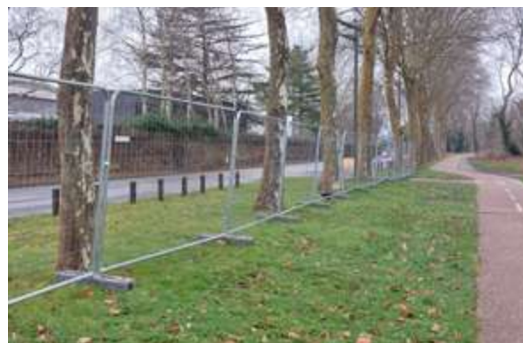
Une partie de la bande enherbée longeant les arbres est délimitée par une rubalise afin de prévenir toute circulation d'engins. Le fait qu'une seule entreprise intervient sur le chantier facilite la diffusion des messages de prévention et de prudence, notamment vis-à-vis des arbres. L'autre partie servira de zone de stockage mais avec des supports limitant la compaction du sol.
