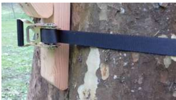
Les câbles ont écrasé la cale en bois et comprimé le tronc. Le nouveau système est meilleur puisqu'il a recours à une sangle ajustable.
