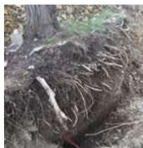
Creusement d'une tranchée au pied d'un arbre et coupe des racines
