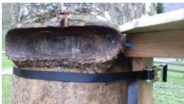
Le système d'accroche de ce parcours d'accrobranche n'a fait l'objet d'aucune maintenance, par ailleurs non anticipée.
