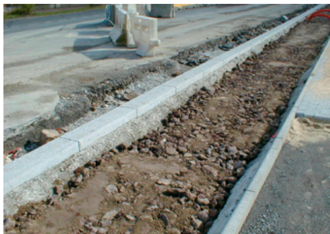
Compaction du mélange terre-pierres par couches, dans une tranchée continue.
