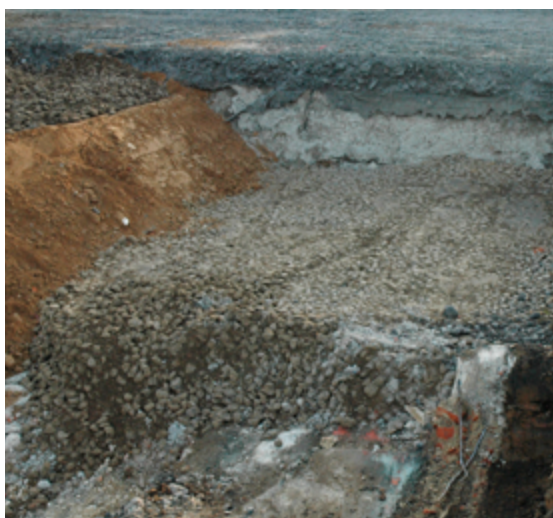
L'espace d'enracinement en mélange terre-pierres est en connexion avec le sol en place.
