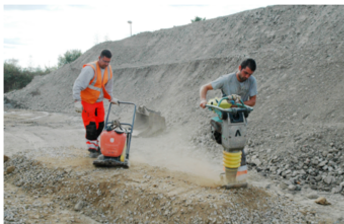
La dalle vibrante (à gauche) n'est pas assez puissante pour compacter correctement ; il faut une pilonneuse (à droite).
