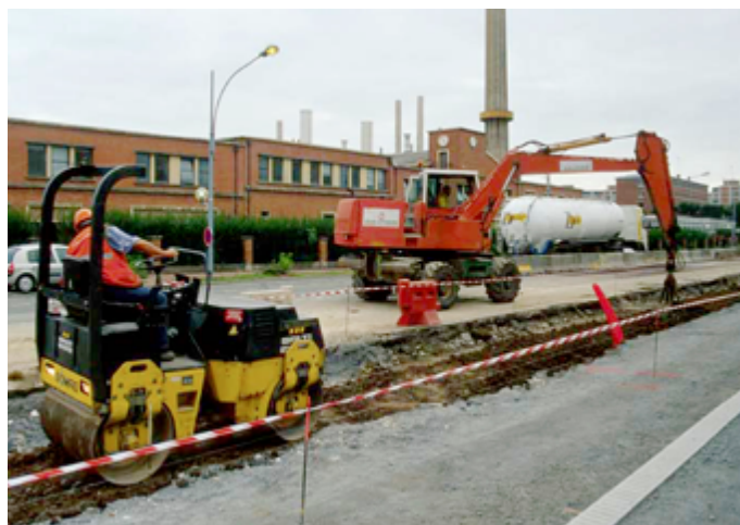
Compaction du mélange terre-pierres par couches, dans une tranchée continue.
