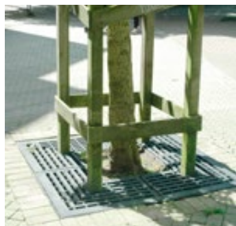
La grille comporte des réservations pour les tuteurs.
