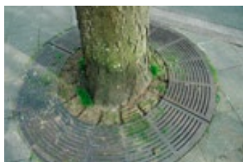
Même grille après découpe et élargissement de l'ouverture centrale.
