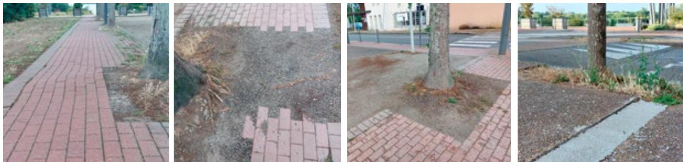
Les féviers d'Amérique ont poussé de façon tout à fait normale et se sont installés au détriment des trottoirs recouverts de pavés autobloquants et des abords traités en dalle béton. Les matériaux d'origine ont été remplacés localement par un sable stabilisé rétablissant ainsi le confort d'usage dû aux promeneurs. Les dalles béton ont été coupées et un rajout en ciment forme un chanfrein.
