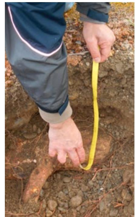
Sondage racinaire sur un parking. Décroûtement et retrait des matériaux de surface au tractopelle, puis travail manuel avant la mesure et l'observation des racines.
