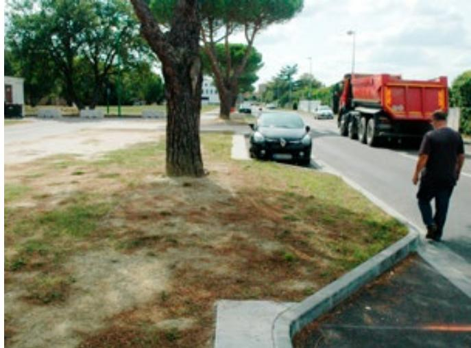
Les places de stationnement au pied de ce pin parasol étaient devenues impraticables en raison du soulèvement des enrobés. Il a été choisi de supprimer localement les places de stationnement et d'élargir l'espace racinaire. Une barrière anti-racinaire solide (un voile en béton) a été installée au droit des nouvelles bordures afin de préserver la chaussée.
