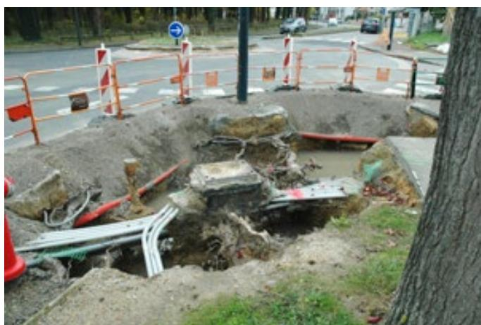
**Le déplacement des réseaux et du regard a nécessité un travail minutieux d'excavation. Les racines du copalme (Liquidambar) ont bousculé les fourreaux des réseaux enterrés et forment un maillage dense. Le problème ici était plus lié au repositionnement des réseaux et de la nouvelle chambre enterrée que les désordres provoqués par les racines.**
