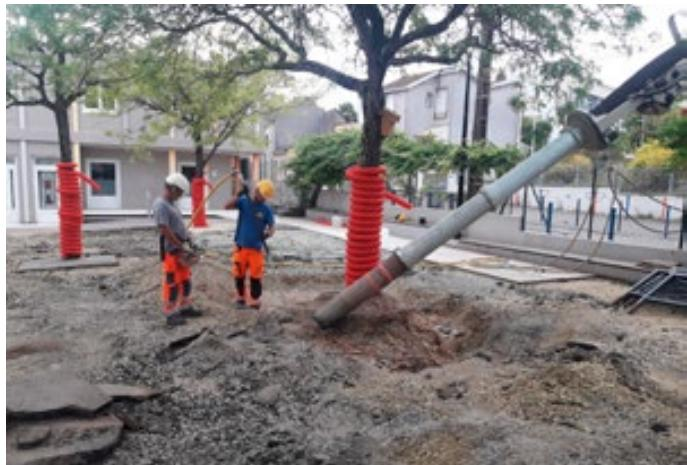
Opération de désimperméabilisation d'une cours d'école à Nantes. Si les travaux sont réalisés avec soin, avec une pioche à air et une aspiratrice (comme ici), les arbres en tireront bénéfice et les sols également.
