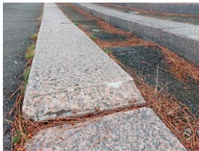
**Chanfrein réalisé sur une bordure en granit soulevée par les racines d'un pin parasol.**
