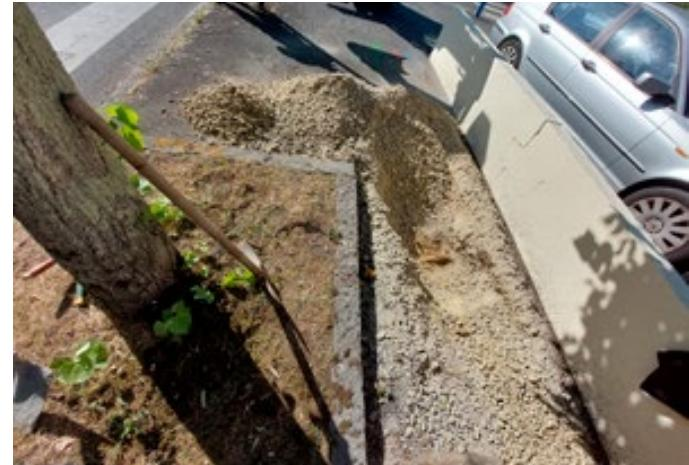
Les racines des arbres d'alignement (tilleuls et tulipiers) sont passées sous les fondations des murets des propriétés bordant la rue et ont provoqué leur fissuration. Les sondages menés par les services de Nantes Métropole étaient destinés à vérifier l'implication des racines dans les désordres constatés.
