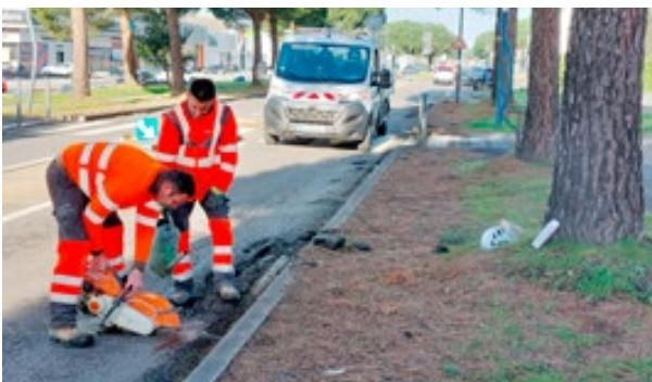
La Route de Vannes est plantée de pins parasols. Les racines de ces arbres déforment les enrobés de la chaussée. Des sondages ont permis d'observer la présence des racines et leur répartition dans le sol.
