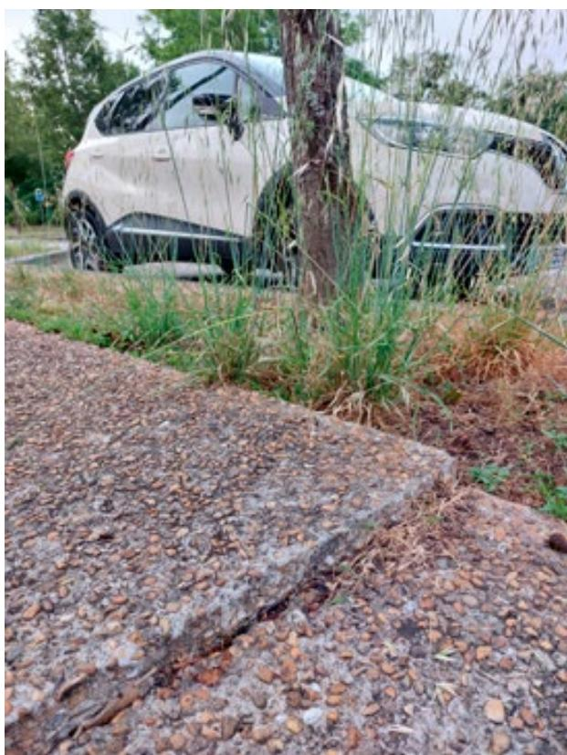
Soulèvement de la dalle en béton gravillonné du trottoir par un poirier Chantecler.
