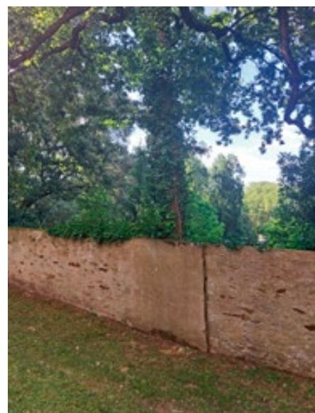
Les arbres du terrain privé situé au-dessus de la route exercent une poussée sur le mur qui surplombe la rue. Le mur est fissuré et menace de tomber. Un système temporaire a été posé en guise de contrefort.
