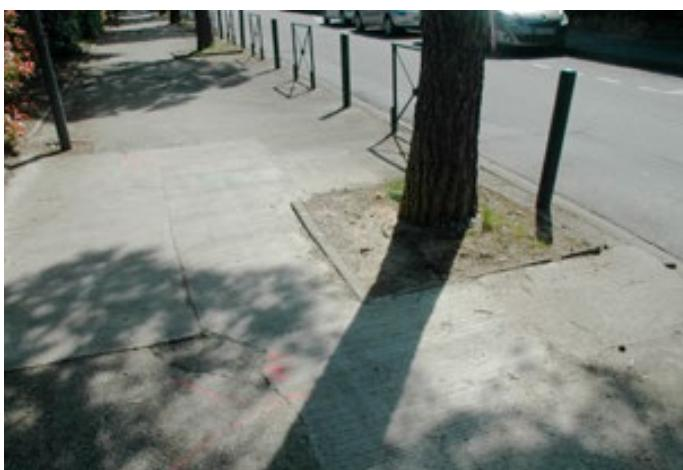
Pour réparer le trottoir en béton soulevé ou fissuré par les racines des pins parasols, il a été choisi d'agrandir les espaces de pleine terre selon une bande continue mais aussi de gagner sur la voie. Les matériaux de voirie ont été retirés et remplacés par de la terre végétale sur une épaisseur de 50 cm.
