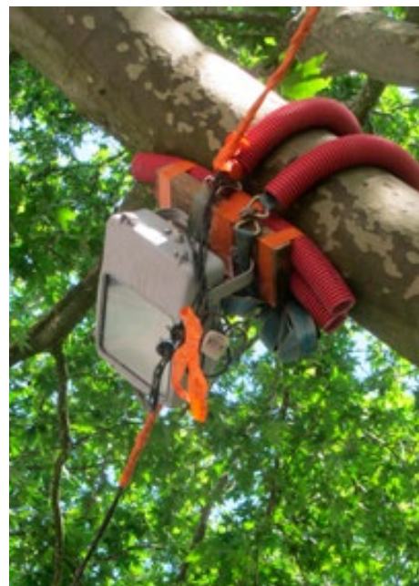
Système sophistiqué, et révisable, de fixation d'un éclairage de chantier sur la branche d'un platane.
