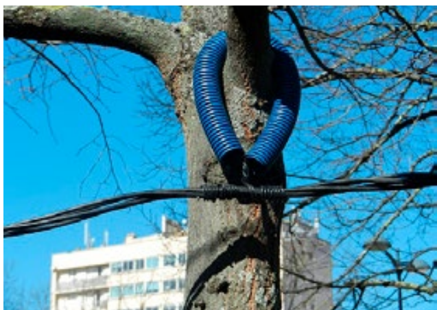
Le câble est soutenu par une sangle elle-même passée dans un tuyau, autour d'une branche. Le risque de blessure par frottement ou par étranglement est supprimé.
