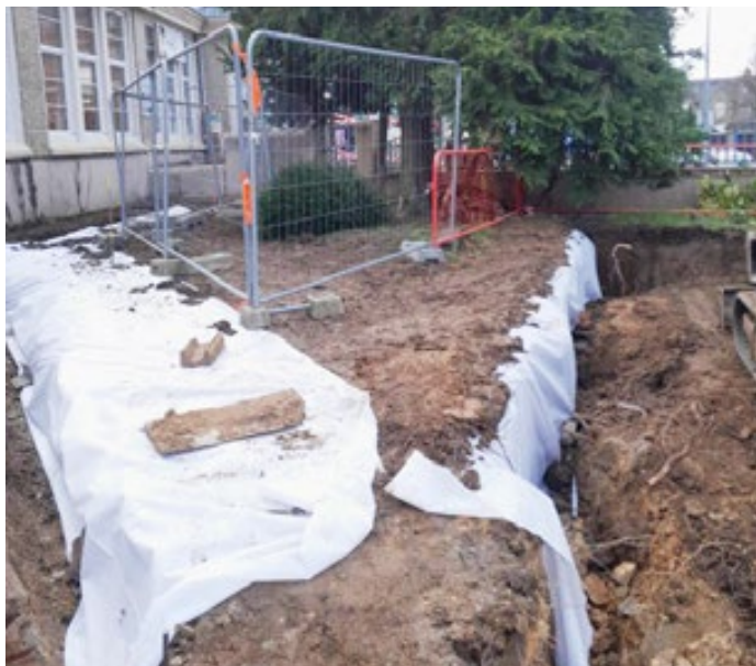
La bâche en géotextile a été installée pour protéger le front des terrassements contre les éventuels assèchements : la bâche est disposée en double couche, lestée à sa base et en surface. Exemple à Nantes.
