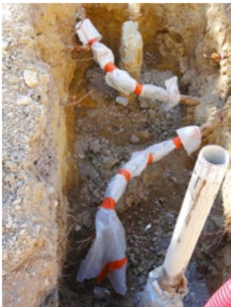
Les racines mises à nu lors des terrassements ont été conservées, et sont préservées du dessèchement par leur confinement dans une bâche plastique. Exemple à Montpellier.
