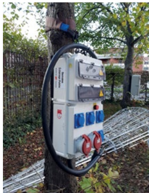
Essai (réussi) de fixation d'un coffret électrique sur le tronc d'un tilleul au moyen d'une sangle Tree Save par le service éclairage public de Toulouse.
