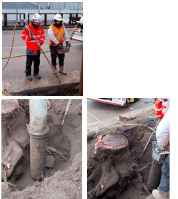
Les mouvements du tuyau de l'aspiratrice (20 cm de diamètre, en métal) peuvent abîmer ou casser les racines (jusqu'à 5 à 7 cm de diamètre). Il est donc impératif de n'utiliser que la lance à air ou la pioche à air. Lorsque la terre est bien meuble, l'aspiration conserve l'intégrité des racines même les plus petites.
