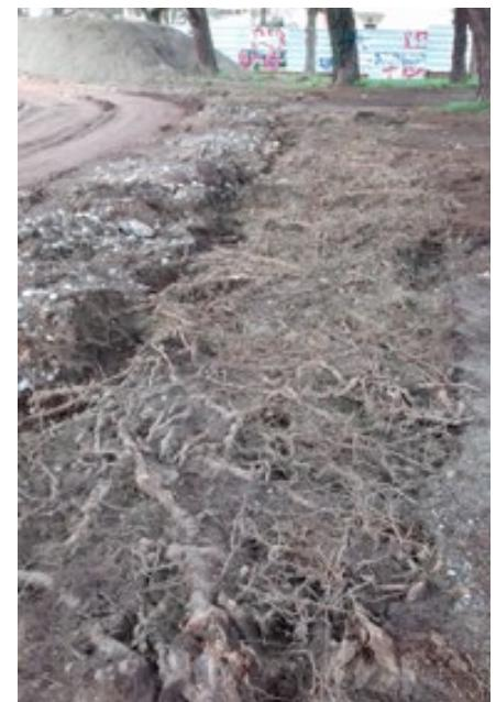
Si l'excavation est réalisée avec une pioche et/ou une lance à air, le résultat est plus que probant, en termes de respect de l'intégrité des racines, même petites.
