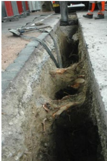
L'aspiratrice et son tuyau de 20 cm de diamètre utilisé directement pour creuser ne permet pas de préserver correctement les racines présentes dans le sol.
